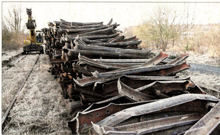
Zwischen Monschau und Kalterherberg werden die Schienen der Vennbahn deinstalliert. Auf der Trasse soll ein Radweg entstehen. (Fotos: Stollenwerk/Kreft)
